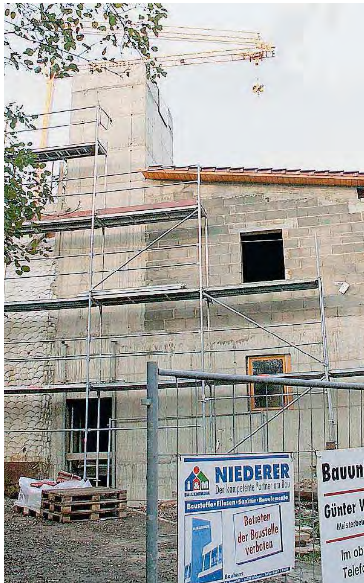
Das Hauptgebäude der Naturbühne Gräfinthal ist derzeit eine Baustelle.
