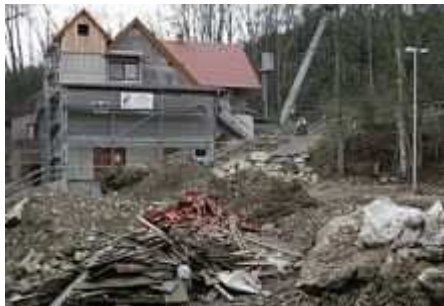
Zum Saisonbeginn sollen die derzeit laufenden umfangreichen Bauarbeiten abgeschlossen sein. Foto: JüS
